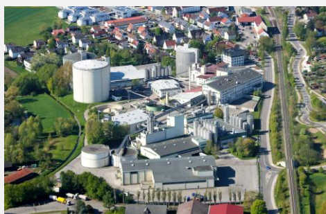
Die Zentrale in Schrobenhausen
